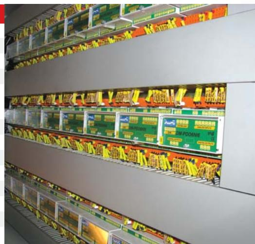
Pomocí modulů řady AMRIO lze řídicí systém rozšířit až o 1512 číslicových nebo 756 analogových vstupů na jedné lince RS485.
